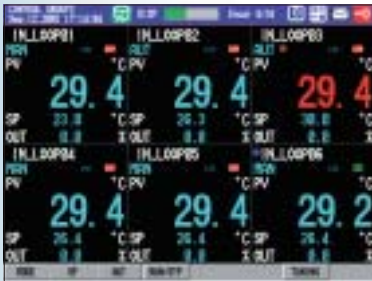
Дисплей-эмулятор контроллера Это дисплей контроля контуров управления. Крупные цифры облегчают визуальный контроль значений переменной процесса (PV).
